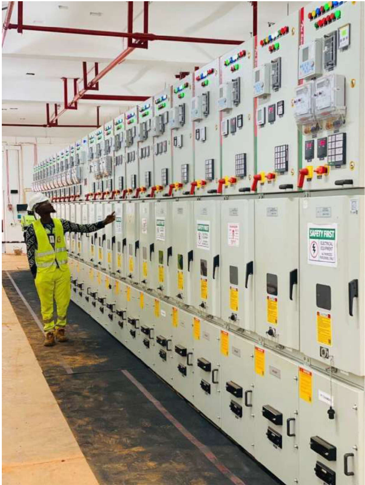
Installation et câblage des cellules MT - Lithium site Galamina (Mali)
