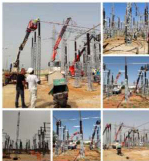
Projet Boucle 225 KV phase 2 _ EESTD Sénégal / Extension des postes 225 KV de Kaolack, Touba 1 & pose des charpentes, des appareillages HT et des raccordements du nouveau poste 225 KV de Fatick
