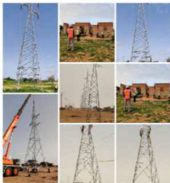
Projet KMS3 _ Cegelec Sénégal / Ligne 90 KV simple terne simple câble du poste 225-90-30 KV de Sakal au poste 90-30 KV de Keur Momar Sarr au Sénégal : Travaux montage de 111 pylônes et déroulage des câbles conducteurs et d'un CGFO sur 30 km
