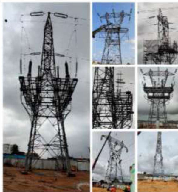
Projet EESTD en Côte d'Ivoire / Passage du poste de Yopougon en 225 KV, Entrée en coupure des lignes 225 KV : Travaux de montage, reprise des câbles de la ligne existante simple terne Azito - Yopougon 2 et remontée des câble aéro souterrain du nouveau pylône 31N type M1S1MW aéro
