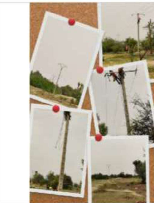
Projet Cegelec Sénégal / Ligne HTA 30 KV Mbour - Fatick d'une longueur de 60 km : Implantation de supports PBA et déroulage des câbles almelec 148 mm2
